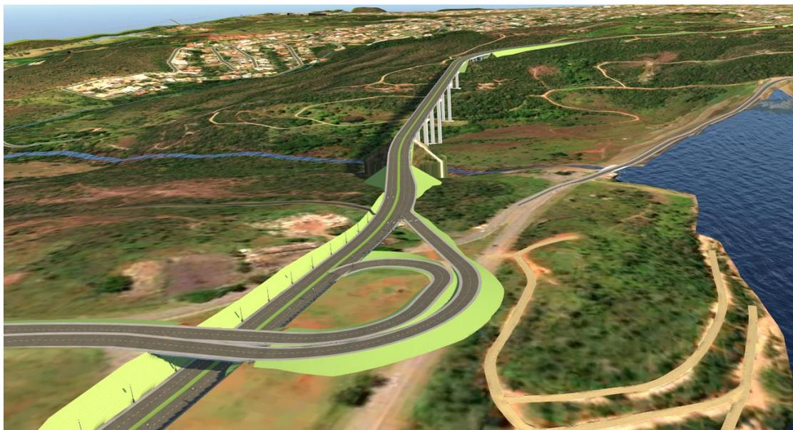
Figura 13 – Possível interseção em desnível na DF-001 x DF-005. Elaboração própria.
